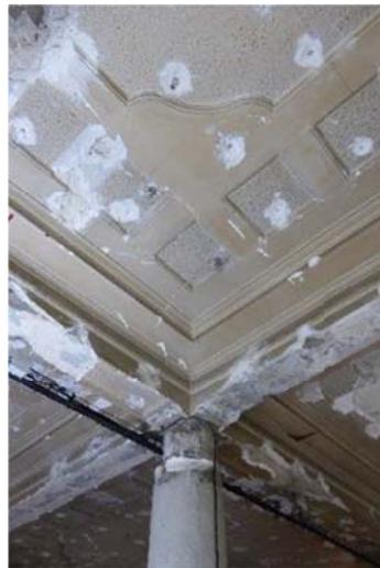
Figura 03.45 - Fragmentos do revestimento dos tectos do piso térreo, caracterizados pela utilização de acabamento estucado e bordadura com sanca. Fotografia do autor.
