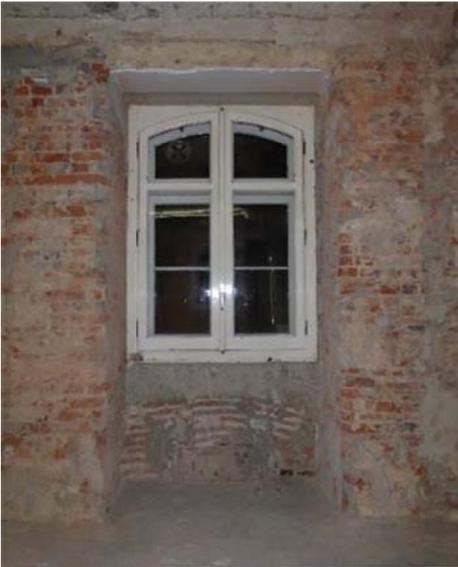
Figura 03.20 - Fotografia interior da fachada do edifício. Notar o arco em tijolo de burro, por baixo do parapeito da janela. Fotografia do autor.
